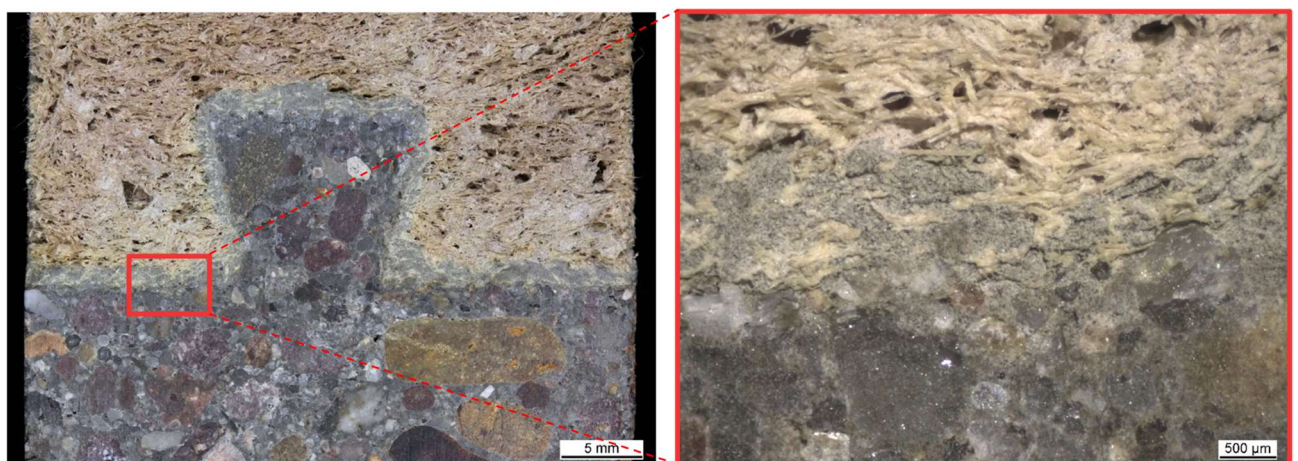
Abbildung 6: Formschluss auf Mikroebene: Detailaufnahme der Holzschaum-Beton-Grenzschicht (Lichtmikroskop)
